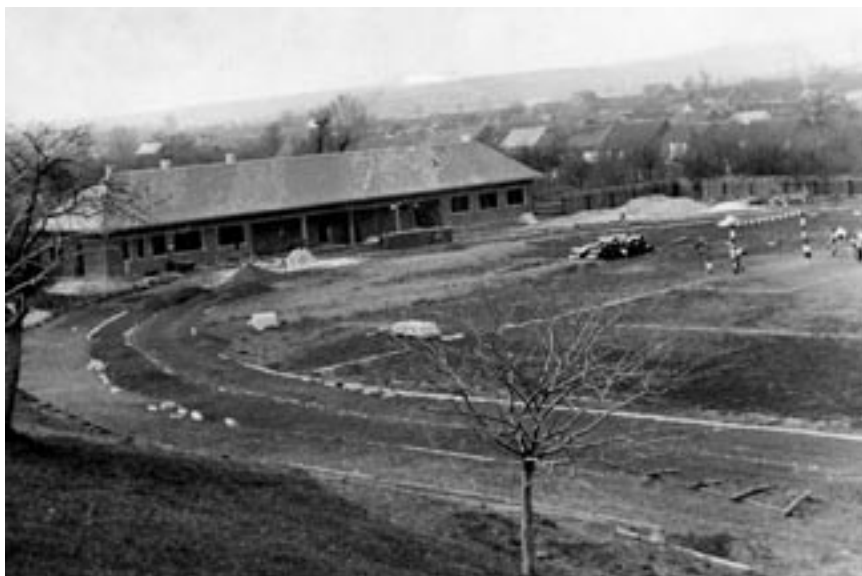
Dokončovací práce na šatnách v Kaštanci
